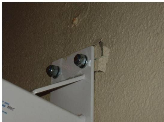
Fig. 8. Fixação Solta
